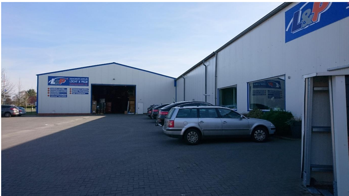
Bild 1 : Bestandsgebäude entlang Hauptstraße (Nördliche Ansicht)
