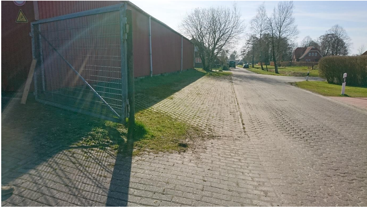
Bild 2 : Bestandsgebäude entlang Alte Süderwieke (Westliche Ansicht)
